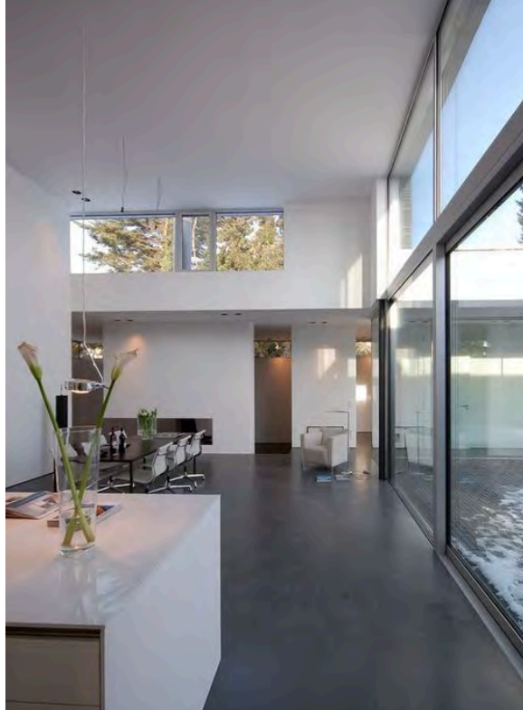
Pavimento Slurry Slurry screed
